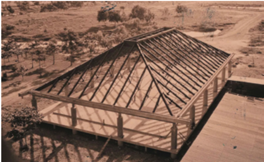
圖/ 四大天王禪堂施工中
